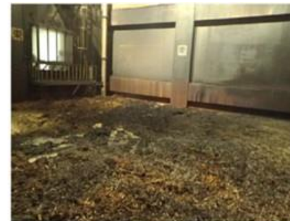
3/7撮影 廃棄物貯留ピット内の状況
