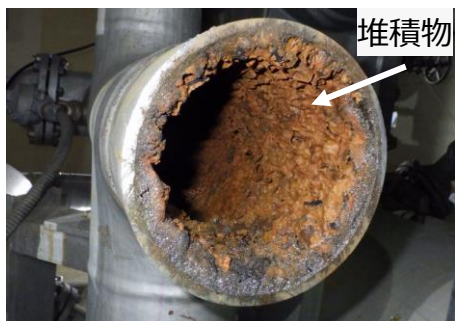
①切断面から上流側を撮影
