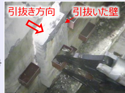
＜壁引抜作業の様子＞
