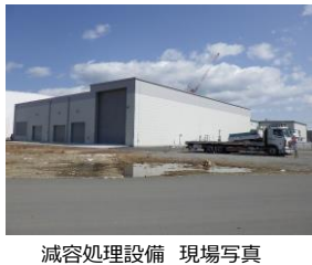
減容処理設備 現場写真
