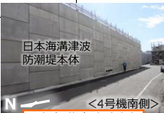
日本海溝津波防潮堤
