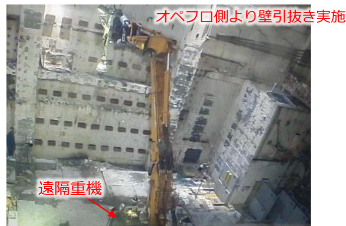
写真②：壁引抜き作業状況
