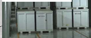
固体廃棄物貯蔵庫
