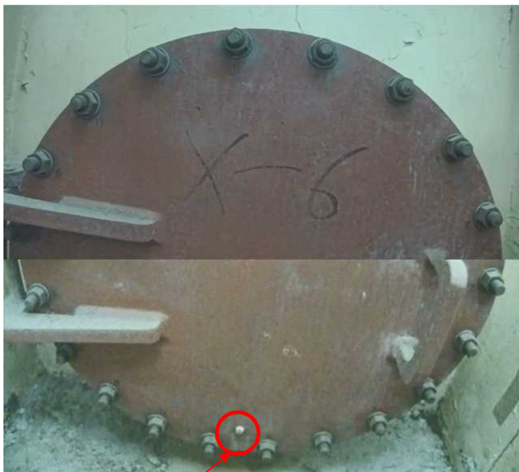
フランジ漏洩試験のためのN 2 封入ライン
