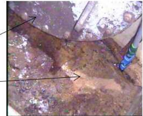
X-6ペネトレーション前の床面 (コンクリートブロック撤去後)
