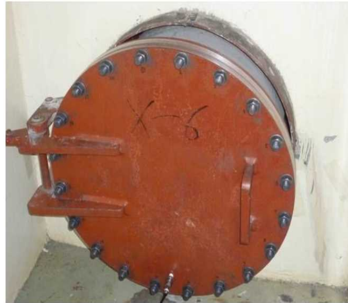
フランジ漏洩 試験時の写真
