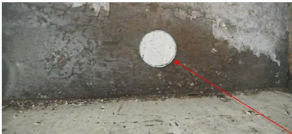
3. 床面 (遮へい壁側)
