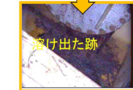
X-6ペネトレーションフランジの溶融物 (コンクリートブロック撤去中)
