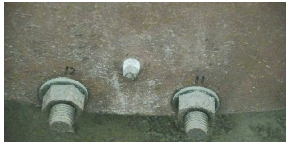
5. フランジ漏洩試験のためのN 2 封入ライン
