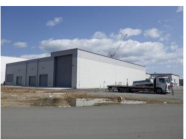
減容処理設備
