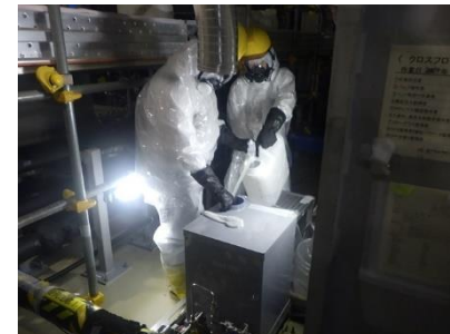
クロスフローフィルター洗浄作業
