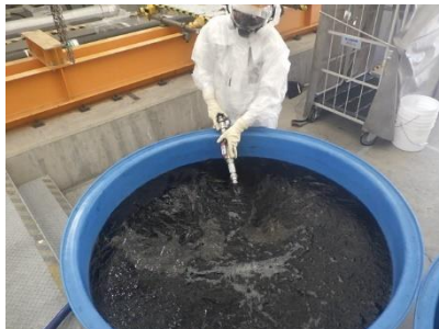
吸着材交換作業
