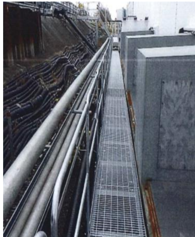
(例) 既設ALPS建屋 屋外 (北側) の歩廊 (本設化)
