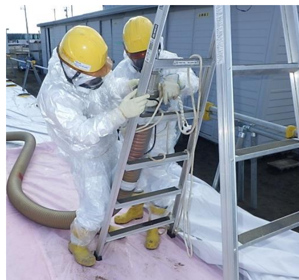
脚立へのホース端部固定作業状況
