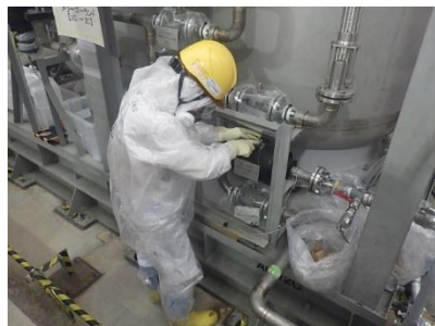
吸着材逆洗作業
