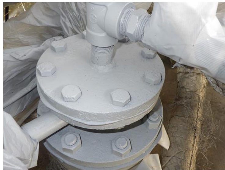
防錆塗装後の凍結管
