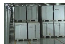
固体廃棄物貯蔵庫
