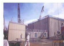
廃スラッジー時保管施設
