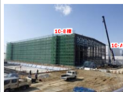
固体废弃物貯蔵庫第10棟
