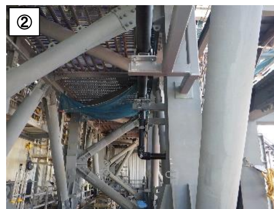
代替注水ライン設置状況（撮影：2月26日）
