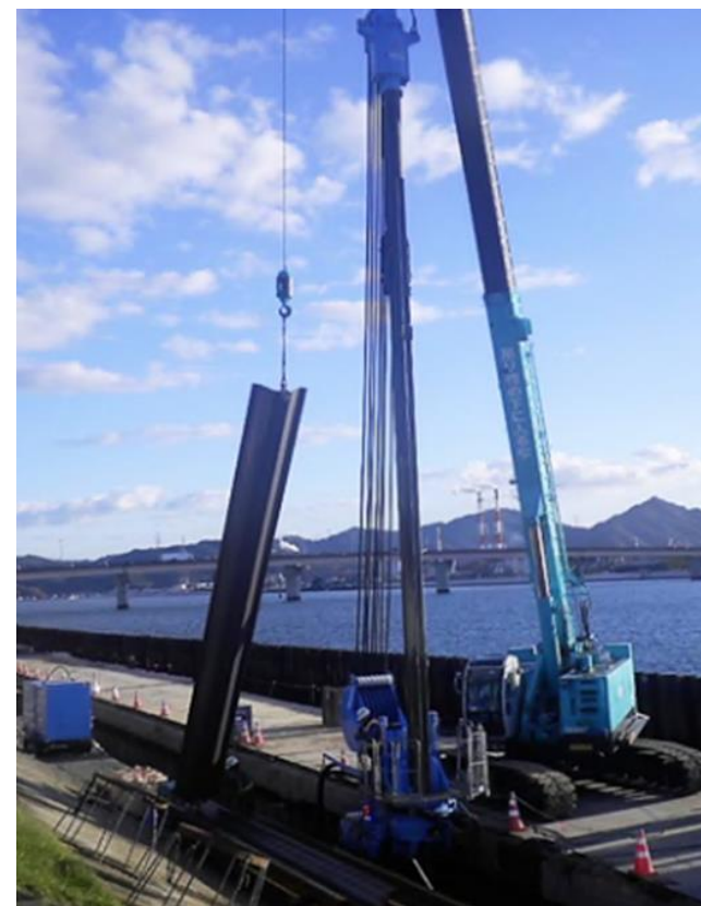
写真 1 施工イメージ
