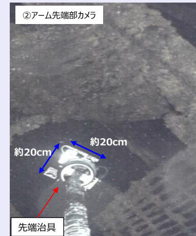
開口2上部の状況
