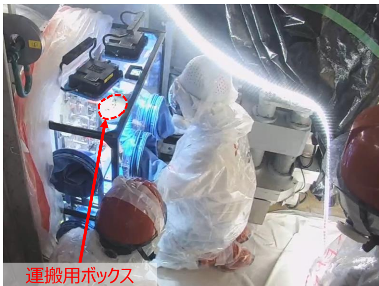
エンクロージャ側面ハッチから 運搬用ボックスを取り出す様子
