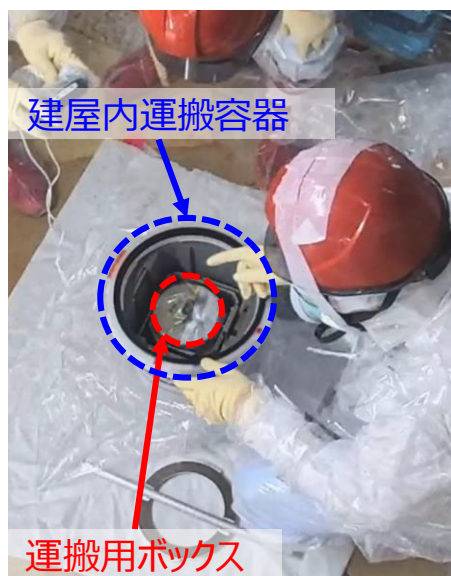
運搬用ボックスを建屋内運搬容器へ 収納する様子
