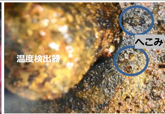
6 温度検出器(鞘管)の下流側
