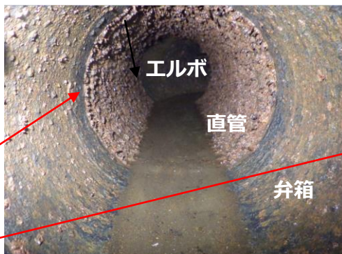
1 直管部(奥)と弁箱(手前)との境目
