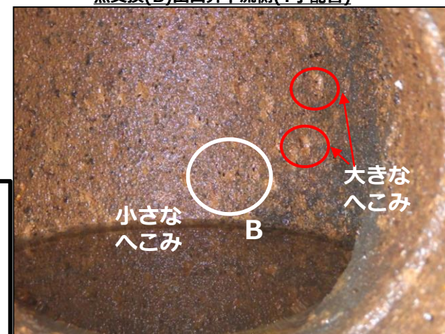
A拡大：熱交換(B)出口弁下流側(T字配管)
