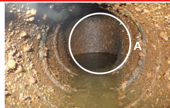
熱交換(B)出口弁下流側(T字配管)
