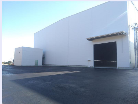
10-C棟の外観（2025年2月17日）
