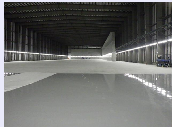
10-C棟の内部（2025年4月7日）
