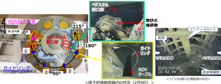
1号機 PCV内部調査実績
