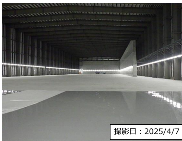
10-C棟の内部
