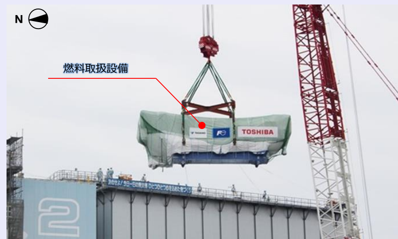
2025年5月30日 燃料取扱設備吊り込み時（屋外）
