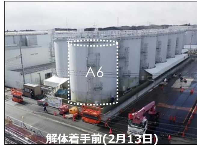
<タンク解体実績表>
