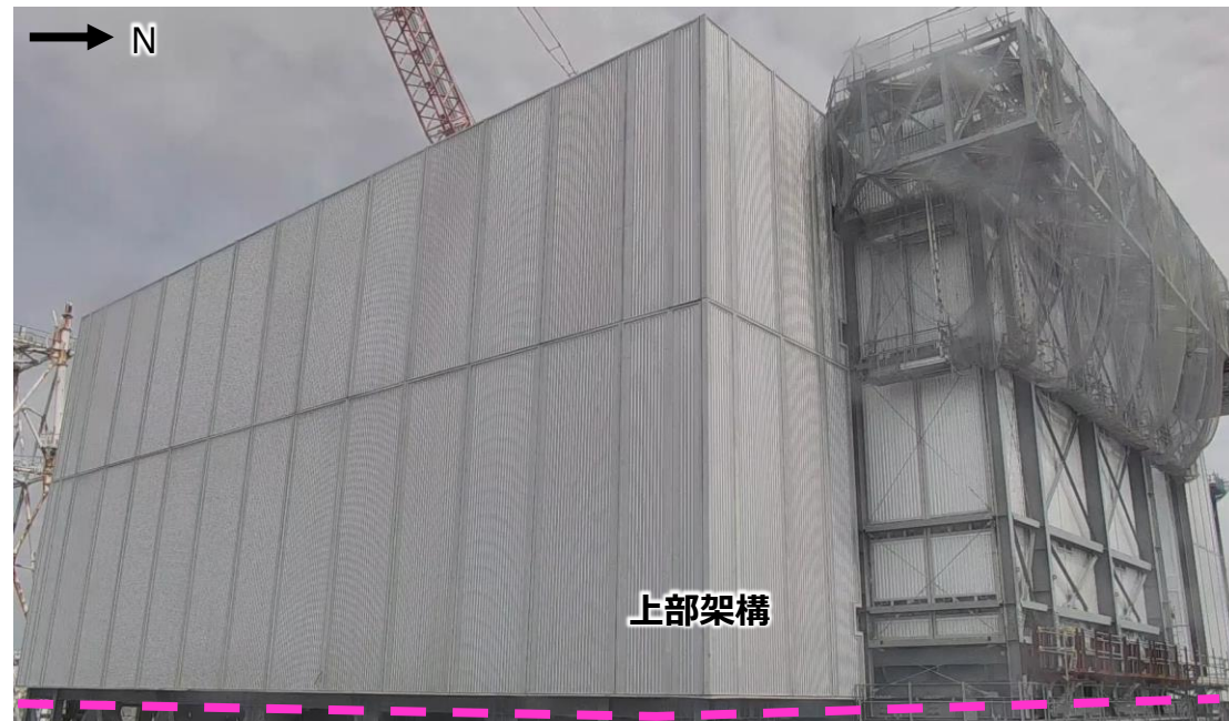
現場状況（南東面） （撮影：2025年6月30日）
