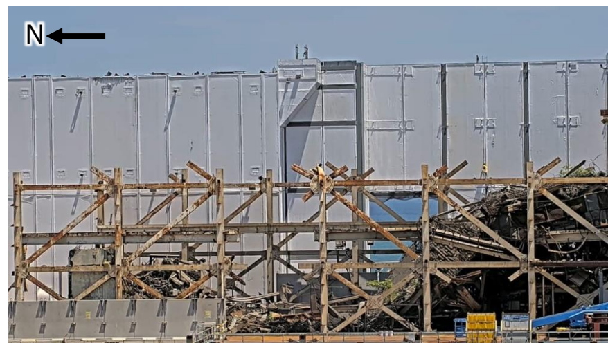
撤去後の全景（撮影：2025年5月23日）
