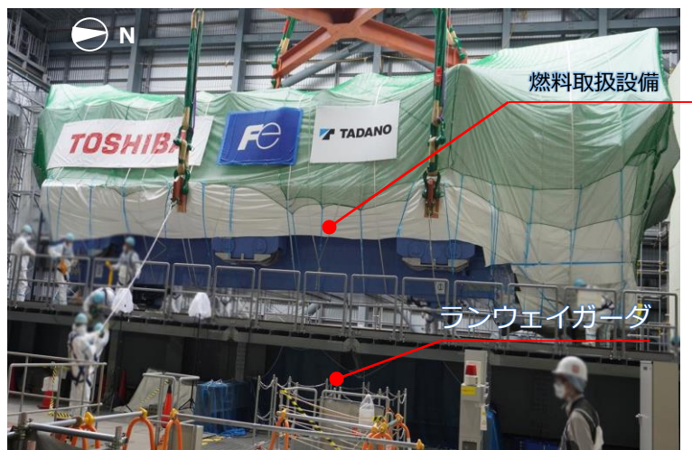
2025年5月30日 燃料取扱設備吊り込み時（構台内）
