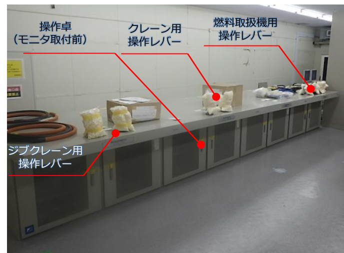
2025年6月11日 遠隔操作室設置状況写真
