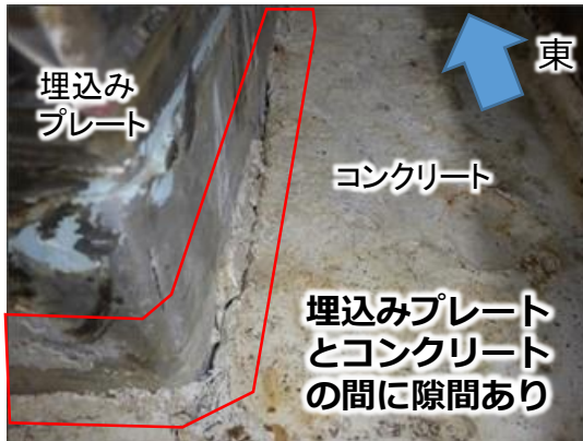
溝形鋼取外し後状況
