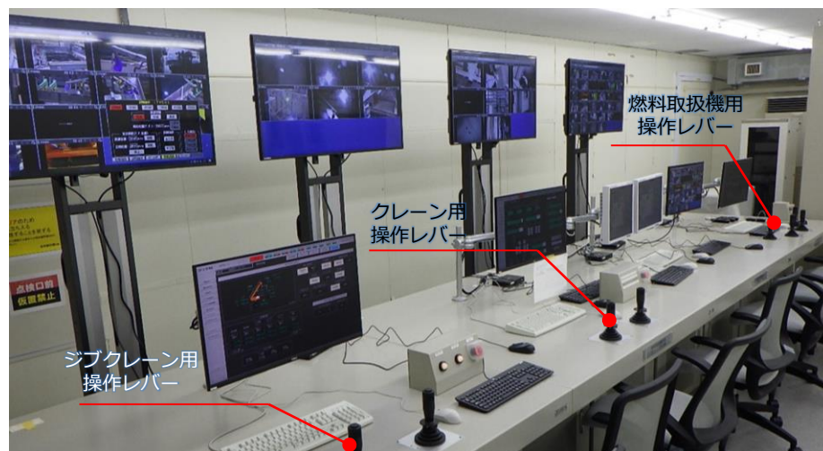
2025年8月22日 遠隔操作室設置状況
