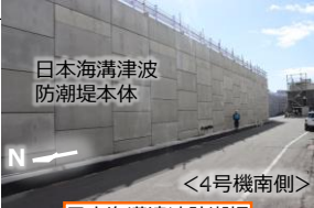
日本海溝津波防潮堤
