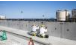
千島海溝津波防潮堤の仕上げ作業
