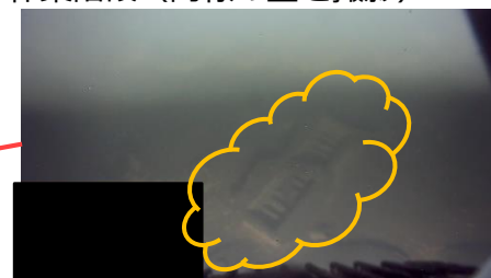
干渉物の例（落下したダクト） ※移動済
