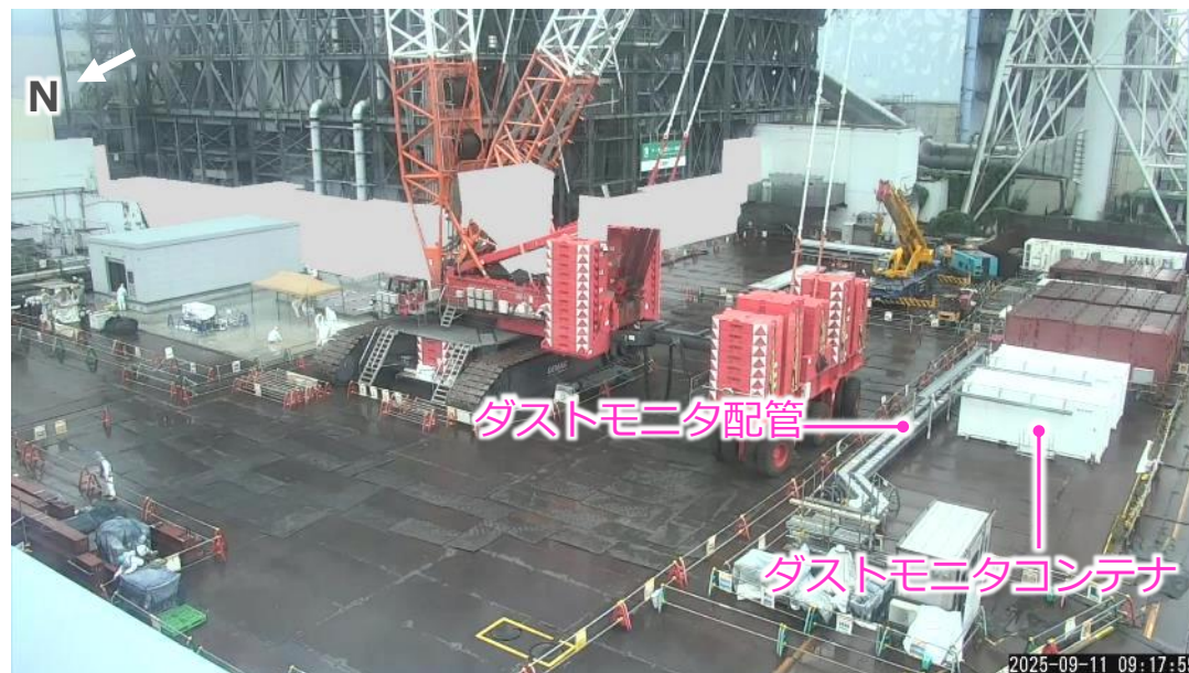
1号機原子炉建屋北西ヤード（撮影：2025年09月11日）
