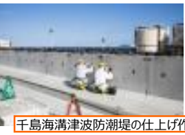
千島海溝津波防潮堤の仕上げ作業
