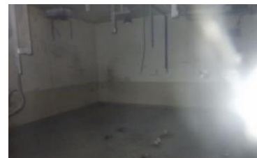
③高圧水はつり除染（床面）
