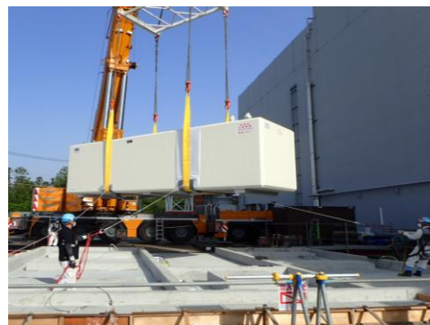
タンク設置作業の状況(2025年5月)
