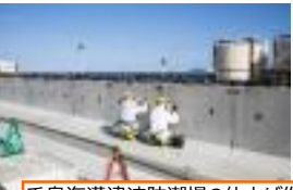
千島海溝津波防潮堤の仕上げ作業
