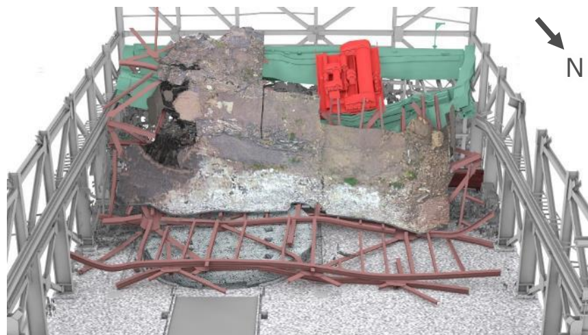
STEP7 : 屋根鉄骨の撤去(全面)
