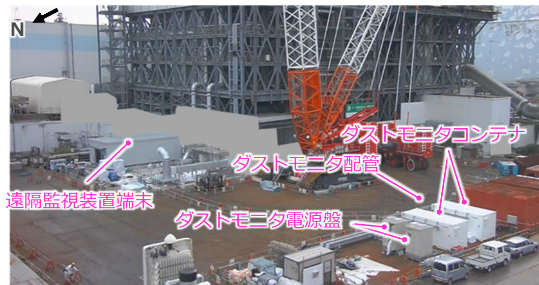
1号機原子炉建屋北西ヤード（撮影：2025年11月13日）
