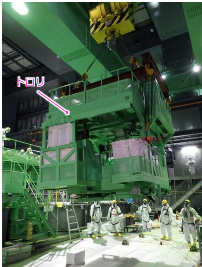
トロリ吊り上げ（撮影：2025年11月12日）
