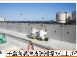
千島海溝津波防潮堤の仕上げ作業
