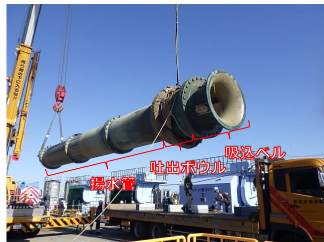
ポンプ吊上げ
