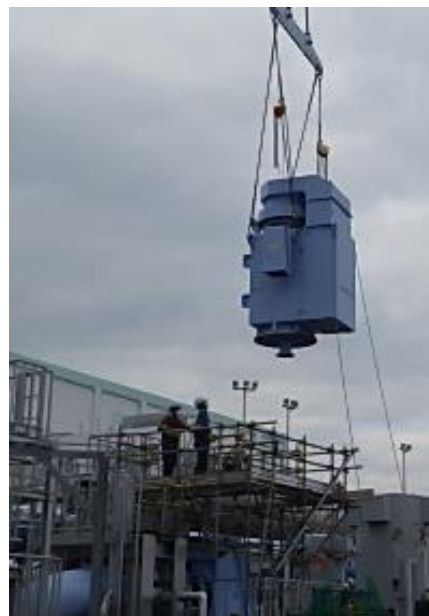
電動機吊上げ
