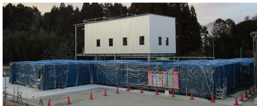
←モックアップ施設の設置状況 水槽は暗闇環境を模擬するために暗幕を設置
