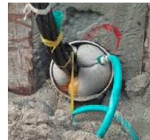
グラウンドアンカー口元止水
