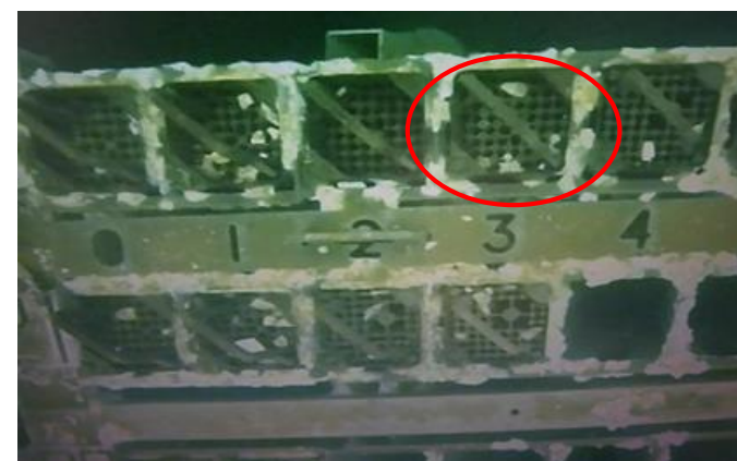
作業完了後（撮影：2025年12月12日）
