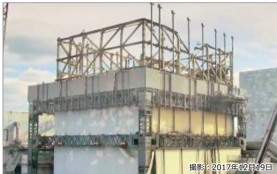
カバー設置前の1号機原子炉建屋
