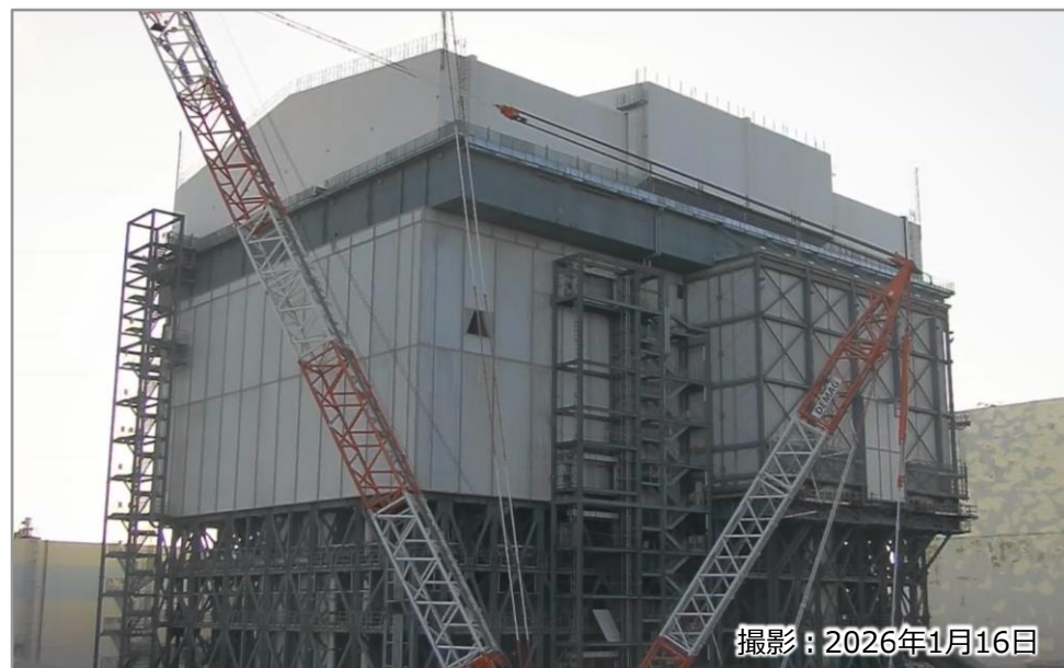
現在の1号機原子炉建屋
