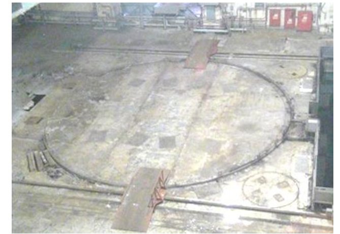
2号機 原子炉ウェル上部
