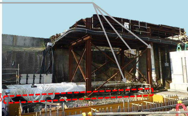
写真_鋼製保護カバー（着手前）
