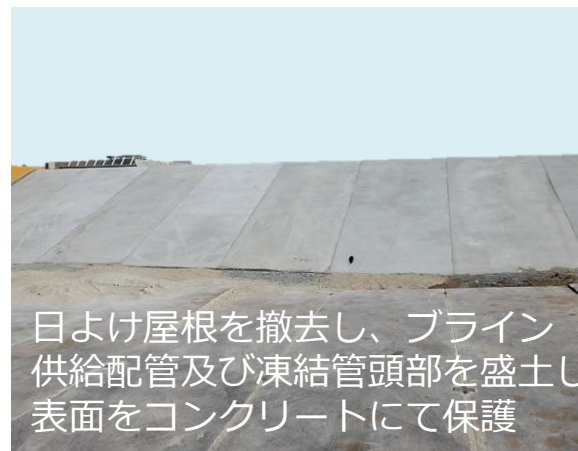
写真_海側盛土部（完成後）
