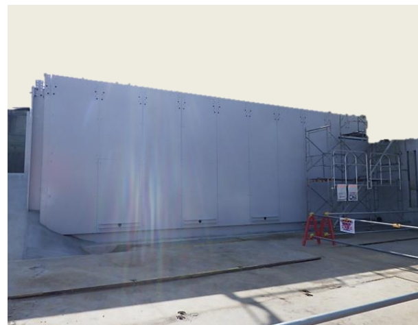
写真_鋼製保護カバー（完成後）
