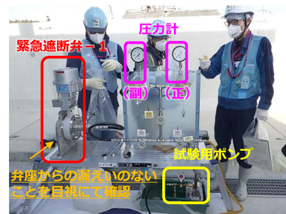
弁座漏えい試験※
