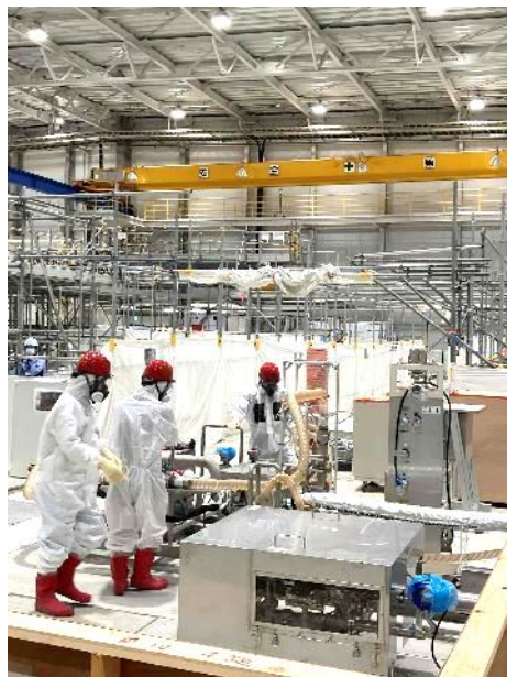
付帯設備の搬送
