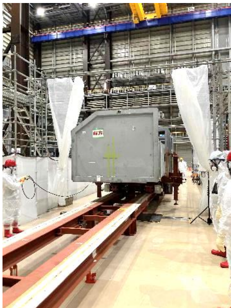
エンクロージャの搬送
