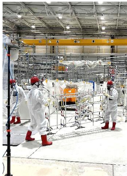
ケーブルラックの設置
