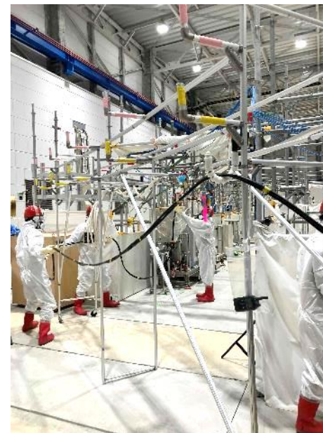
ケーブルの敷設
