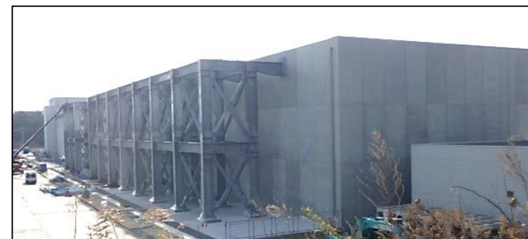
建屋の耐震補強工事の状況
