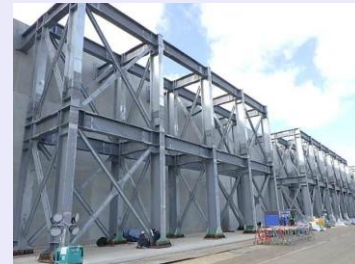
補強工事完了後の状況
