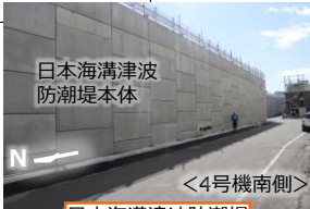
日本海溝津波防潮堤
