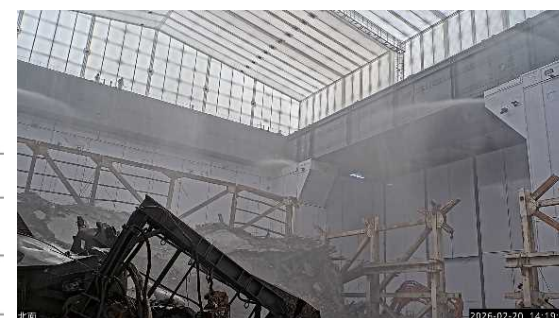
カバー内噴霧状況
