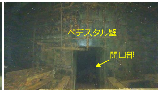
③ : CRD交換用開口 外観
