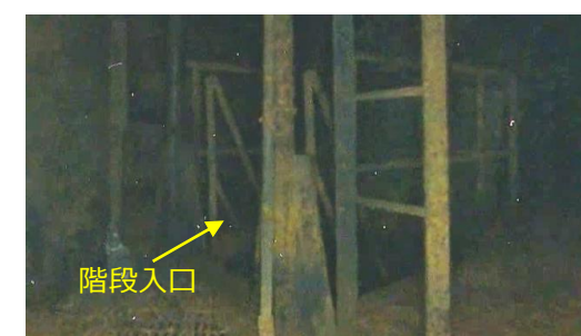
④：地下階段(南)
