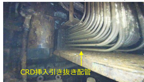
②：CRD挿入引き抜き配管(北東)
