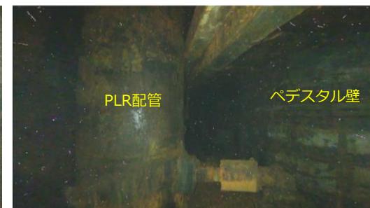
④：ペDESTAL外 東エリア
