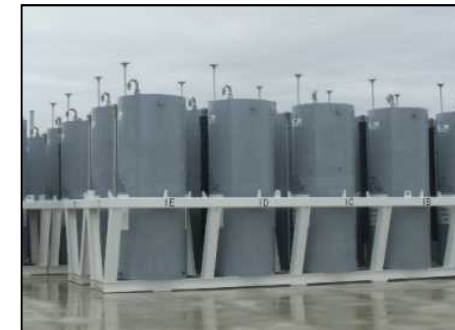
使用済吸着塔屋外一時保管施設 第四施設（SARRY吸着塔保管状況）
