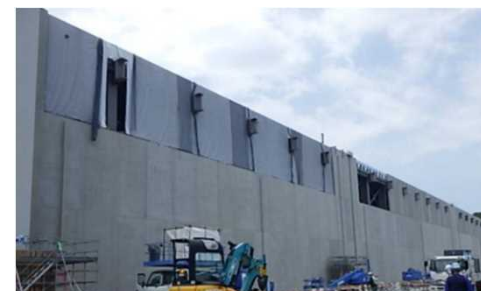
補強工事中の状況
