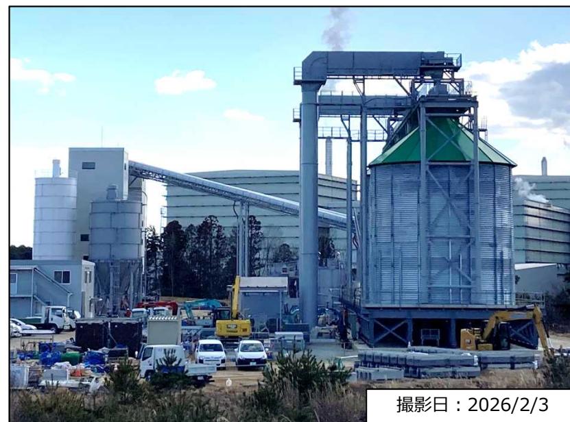
コンクリートプラント全景
