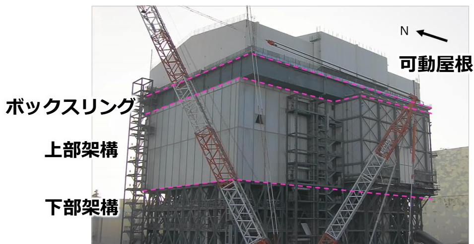
1号機大型カバー現場状況 (撮影：2026年1月16日)
