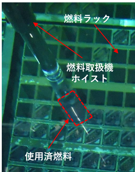
6号機使用済燃料取り出しの様子 (撮影：2025年4月)
